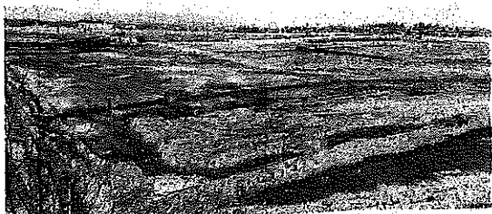
造成工事中 20年4月3日撮影
